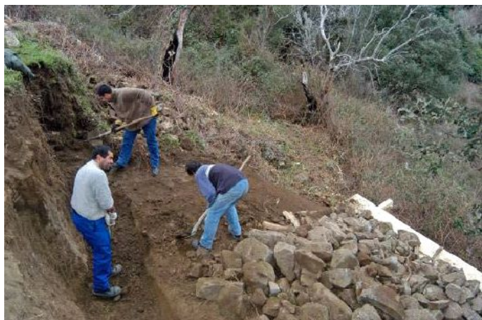
Etapes de déblayage et de fondations
